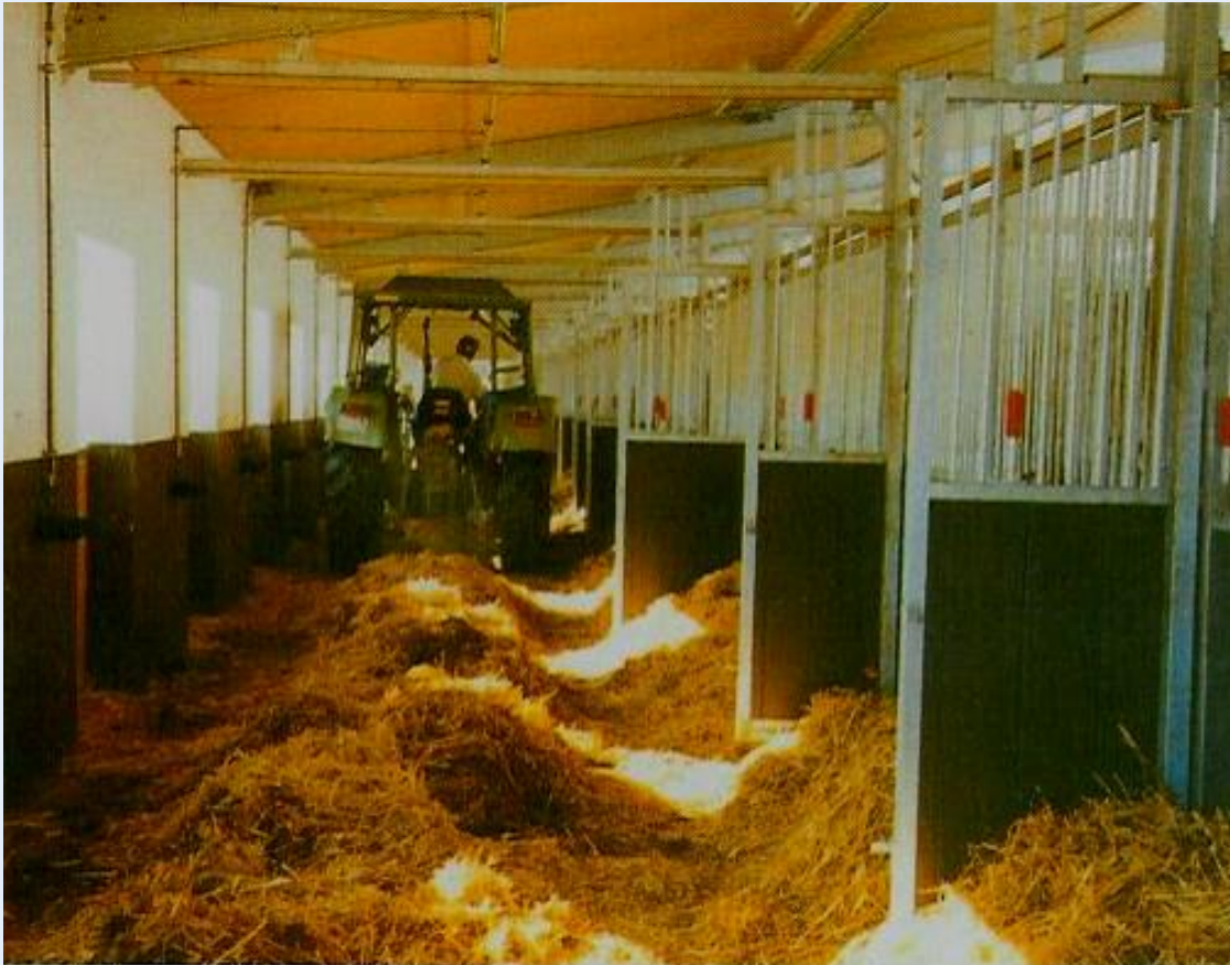
Herausziehbare Trennwände für die Schlepper-Entmistung
