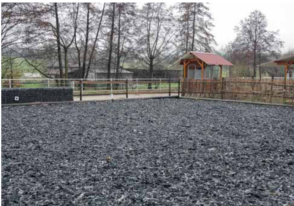
Die Auslauflächen erstrecken sich rund um den Allwetterreitplatz, der mit einem Holzzaun und Gabionen eingefasst ist.
